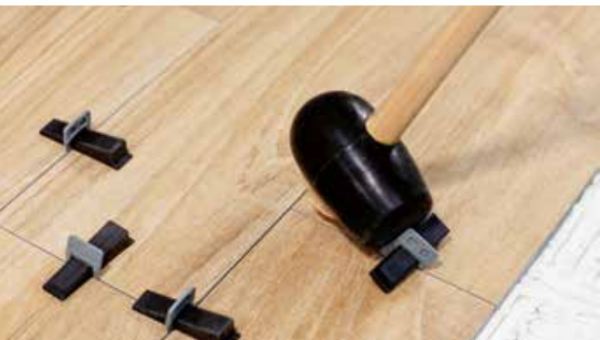
6 Retirar sistema / Retirer le système Remove the system
