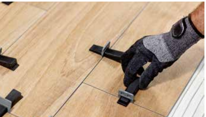
3 Introducir cuñas / Introduire les câles Introduce the wedges
